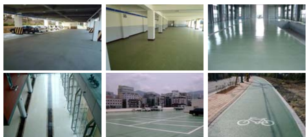
그림 6. 세라믹 마블 불연바닥재의 시공사례
