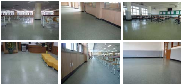
그림 5. 세라믹 마블 불연바닥재의 시공사례
