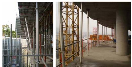
그림 6. 캔틸레버 슬래브의 서포트 설치
