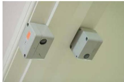
그림 3. 재실 감지 모듈 설치 모습
