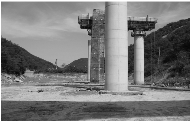
사진 1. 교각공사 중의 사봉소류지 수변(2005.9)
