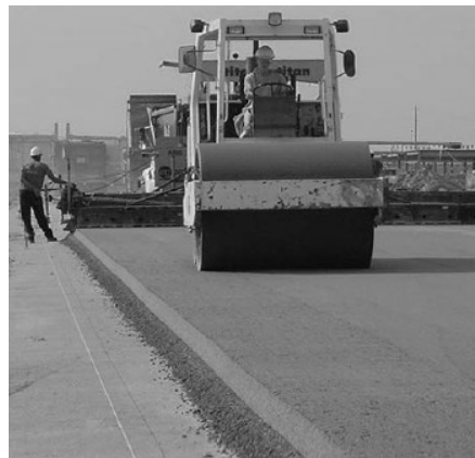
그림 2. 롤러 전압 콘크리트 포장 시공 전경
