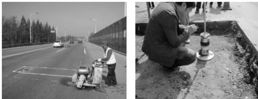
그림 3. 현장시공 후 LFWD 시험 전경
