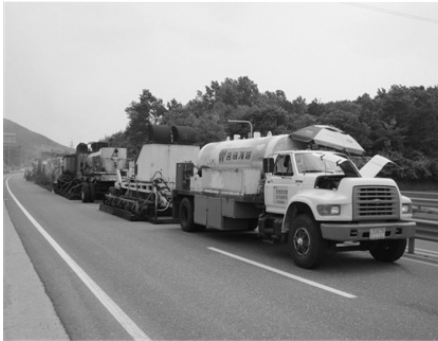
(a) 현장가열재생아스팔트 포장 전경
