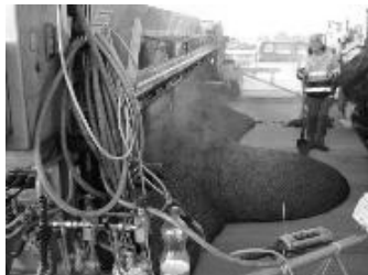
그림 2. Mastic asphalt의 흐름성
