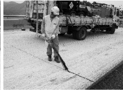
그림 14. 표면처리 및 균열 보수
