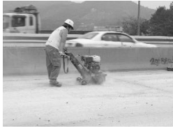
그림 14. 표면처리 및 균열 보수
