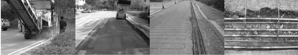
**그림 1. (좌로부터) 아스팔트 포장 절삭 및 용설 시스템 설치를 위한 관로 정비, 용설용 배관 설치 후 전경 및 주 배관 연결부위의 용접 세부**
