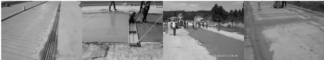
그림 4. (좌로부터) 배관설치, 강섬유 포장 시공, 포장 전경, 줄눈절삭
