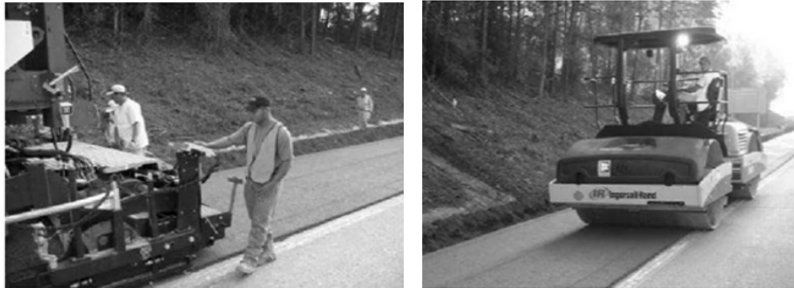
그림 1. 롤러 다짐 콘크리트 포장공법
