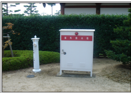
그림 5. 일본의 사찰내 감지시스템 및 소화전설비
