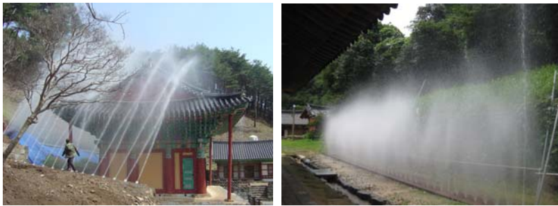
그림 2. 설계 및 운영상 문제된 수막설비 사례
