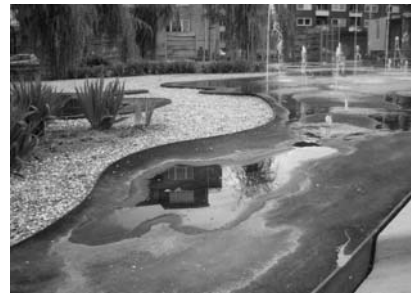
[그림 3] 하루에 일곱 번씩 솟아나는 분수에 의해 콘크리트 바닥에 물웅덩이가 생긴다.
