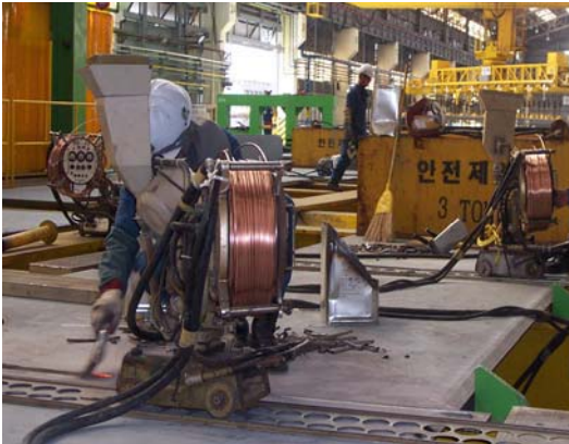
Fig. 8 양면 다층 SAW 용접 작업
