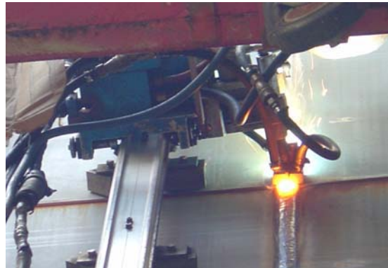
Fig. 10 EGW 용접 작업
