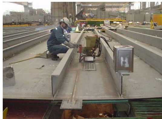
Fig. 6 일면 SAW 용접 작업
