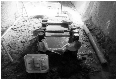
그림 18. 공동구 콘크리트 타설
