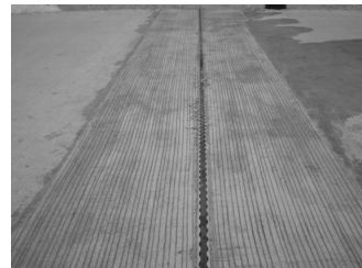
그림 5. 콘크리트 포설 후
