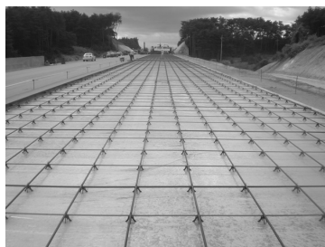
그림 6. 강선 및 철근 배치 완료
