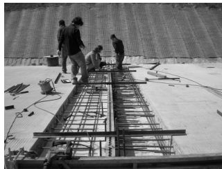
그림 4. 조인트 설치
