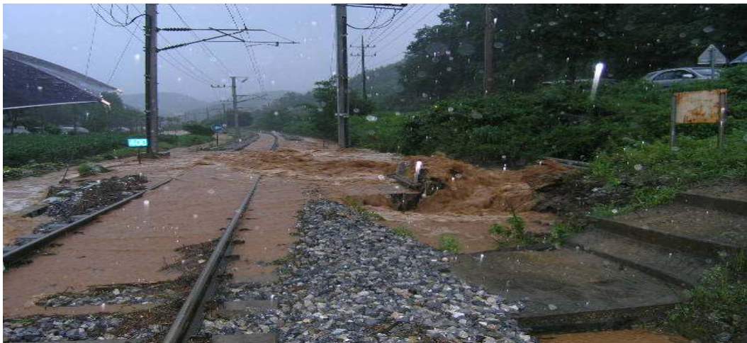
<그림 1> 폭우로 인한 선로침수 및 유실
