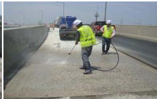
그림 10. 면처리(Gun type 워터젯)
