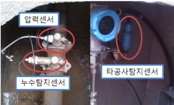
그림 2 맨홀 내부에 설치된 센서들
