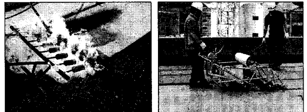
사진 1. 기존시트방수재 시공모습(좌)과 본 개발기술시공모습(우)
