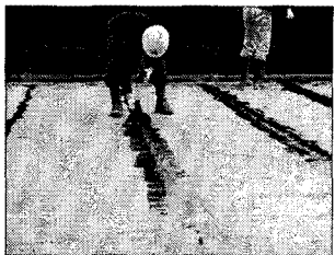
4) 맞댐부 보강 시공
