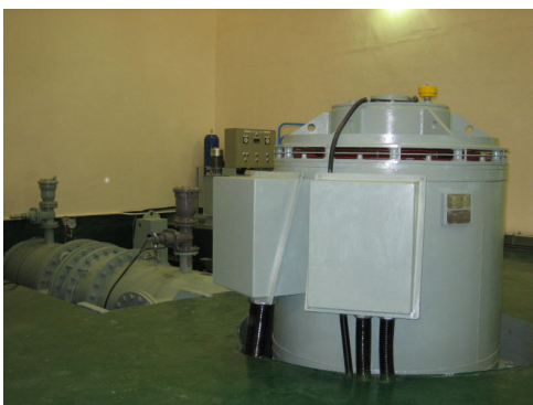
그림 6. 설치완료된 프란시스수차발전기
