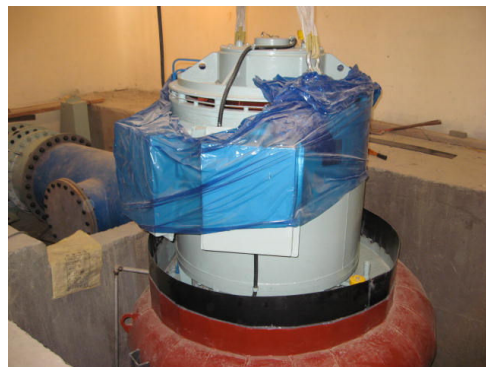
그림 5. 프란시스수차발전기 설치
