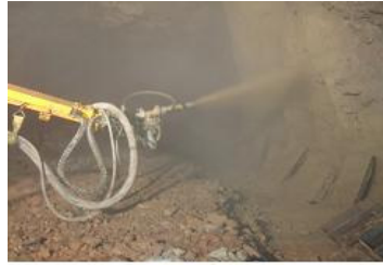
(b) 숯크리트 현장 타설 그림 1. 현장 타설 실험
