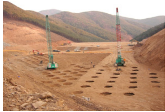
그림 1.2. 동다짐 시공 전경
