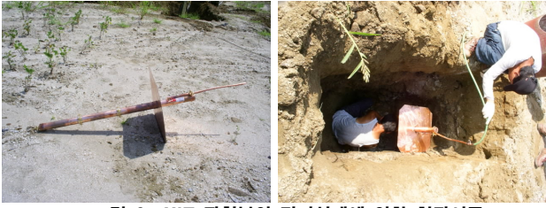
〈그림 6〉 XIT 판형봉의 접지설계에 의한 현장시공
