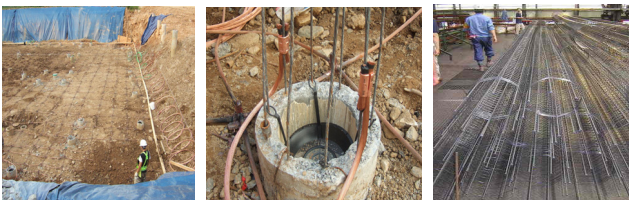
〈그림 4〉 접지시공 공법 사진
