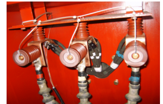
〈그림 12〉 접촉식 센서 설치장면
