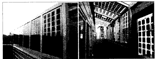
그림 3. PV 모듈의 설치 전경
