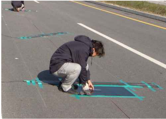
(a) 피에조 센서 설치 모습
