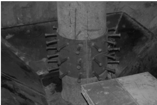
그림 6. 전단연결장치가 연결된 모습
