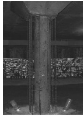
(a) 슬래브 타설 후 CFT 기둥의 모습
