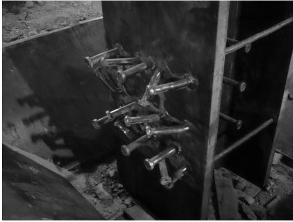
그림 3. 굴토시 전단스티드가 훼손된 모습
