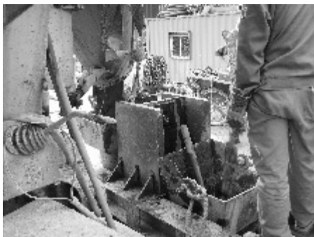
그림 1. H형강 선기초기등 콘크리트 타설 모습
