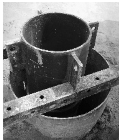
그림 2. CFT 선기초기등 설치 모습
