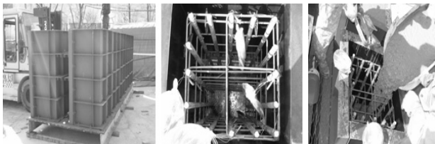
시험체 몰드 철근 및 sensor 설치 콘크리트 타설
