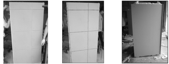
(d) PF보드설치 (e) 이음세보강 (f) 석고보드
