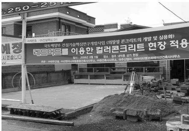
사진 1. 청주 내덕동 상가 현장
