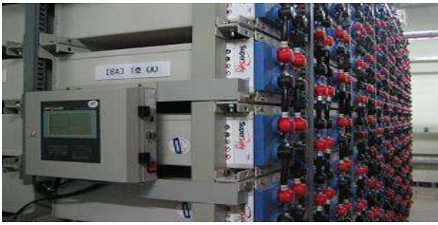
그림 7. 축전지 진단 시스템의 현장 설치 예
