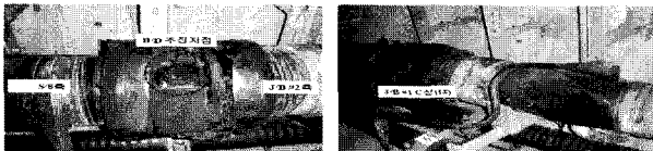
〈그림 1〉 154kV 지중송전선로 고장형상
