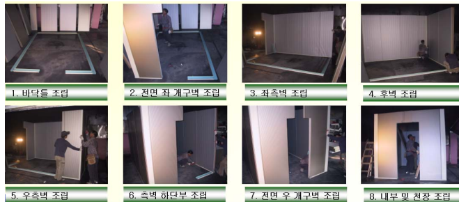
그림 1. 시험체 조립도(좌) 및 실제 시공모습 (우)
