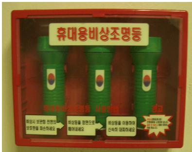
그림 1 휴대용비상조명등의 설치 예
