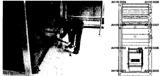
Fig. 5 건물 내 공조실 Impact Hammer를 이용한 충격하중 재하 전경 및 충격하중 재하 위치
