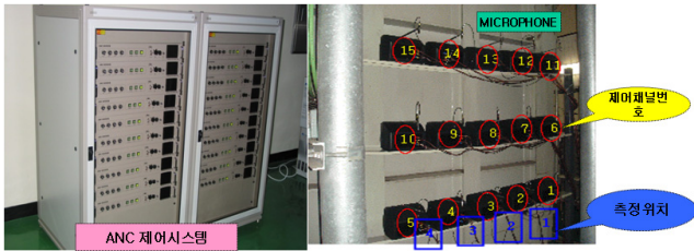
<그림 4> 다채널 ANC시스템 및 제어출력 위치
