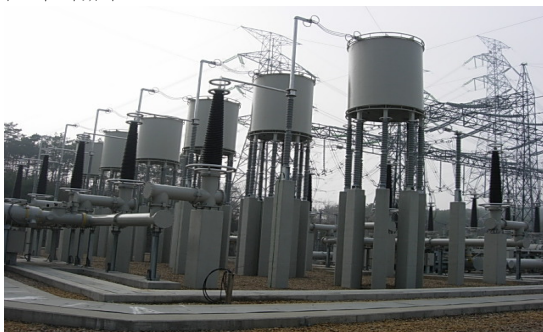
<그림 3> 콘크리트 기초 시공사진
