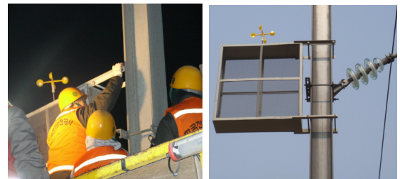
〈그림 7〉 외부요인 검출을 위한 비산물 검출망 설치전경
