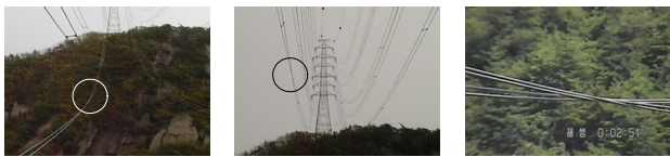
〈그림 6〉 전력선의 꼬임 (kissing)
