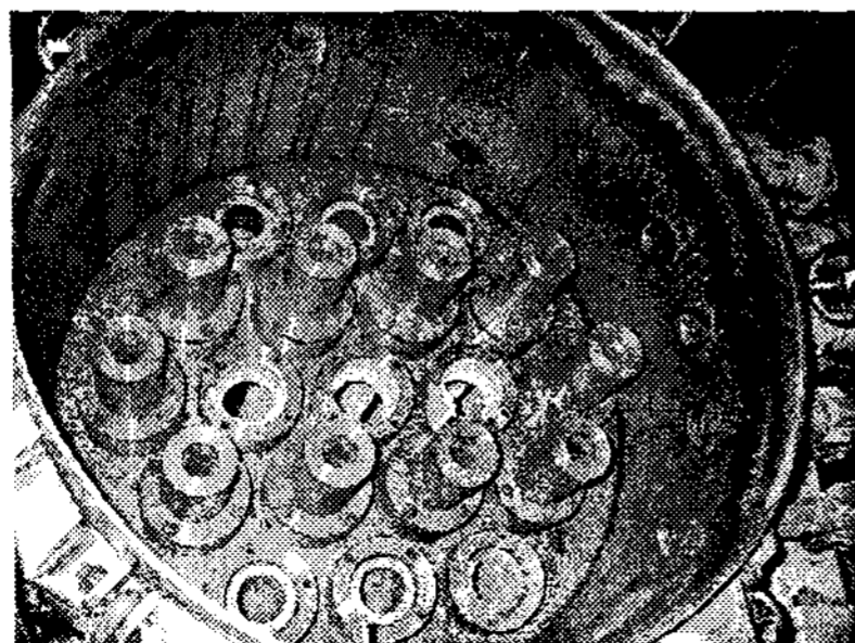
(a) Tube Sheet 필터여재가 장착된 모습
