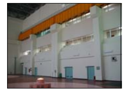
(d) 지하 1층 수차발전기실의 우측
