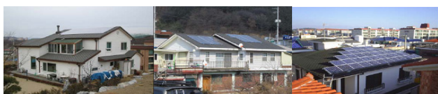
〈그림 1〉 지붕형 PV모듈 설치 사례
