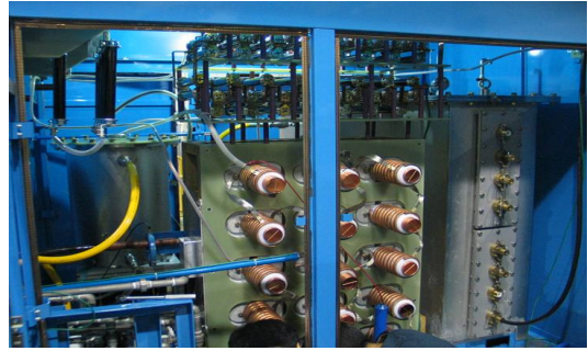
그림 3. 모듈레이터 관널내부 Fig. 3. Modulator panel.
