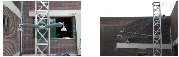
<그림 5> 자주조립식 철주의 절연암 설치
