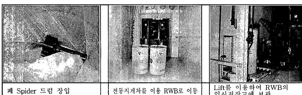
원자로 헤드 분해 후 상부 안내구조물(Upper Guide Structure) 인양 하여 상부구조를 안착대에 안착 시킨다. 상부구조물에서 ESA(Extension Shaft Assembly)와 CEA(Control Element Assembly) 분리작업을 시행한다. 분리된 CEA는 작업 Tool를 사용 수면 30cm정도 까지 인양하여 Crimping Nut 제거 후 Spider를 인양 해 준비된 차폐 용기로 운반 처리한다. Spider가 제거된 제어봉은 절단하여 바스켓에 넣어 사용후 핵연료다발을 보관하는 수조에 보관 한다. 제거한 Crimping Nut 및 Spider는 사전 제작된 전용 차폐 운반 용기함에 넣어 발생 즉시 처리 하여 임시 저장용 차폐드럼에 운반 및 저장한다. 제거한 Crimping Nut 및 Spider 6~8개가 한 드럼에 채워지면 폐기물 처리건물 임시저장소로 이동 보관한다.
