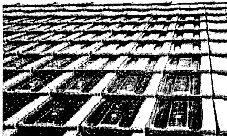
그림 2 아스팔트지붕이나 타입으로 제작된 PV모듈을 적용한 예
