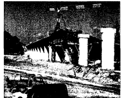
그림 1. 계측대상 교량의 시공 전경
