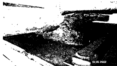
그림 2. 콘크리트 적치로 인한 받침 가동불량
