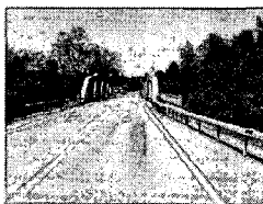
그림 1 Bentley Creek 복합재료 교량상판 구조물 (New York, USA)
