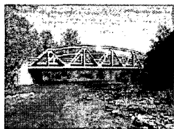
그림 1 Bentley Creek 복합재료 교량상판 구조물 (New York, USA)
